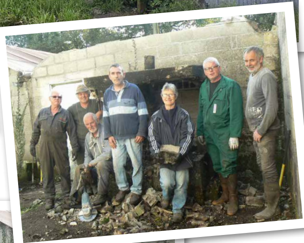
Démolition du vieux fumoir à l'arrière du commerce « Epi service »
